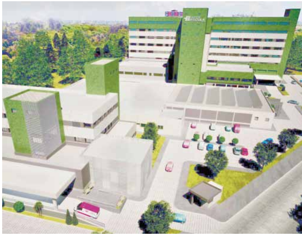
Vista parcial do projeto
