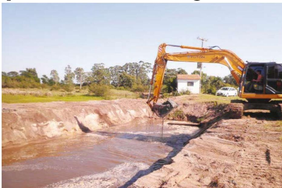
Escavadeira hidráulica limpa o canal de captação
